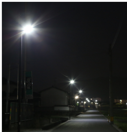
▲設置された防犯外灯。
