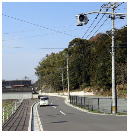
▲整備が完了した土居・瀬戸線。
