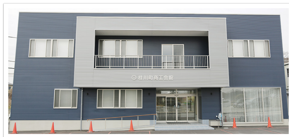
▲新築移転した「桂川町商工会館」。
