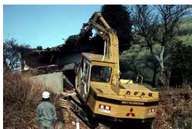
図 2-92：覆屋の解体(昭和 62 (1987) 年度)
