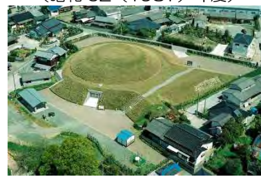
図 2-96：保存整備工事後の王塚古墳(平成 5 (1993) 年度)
