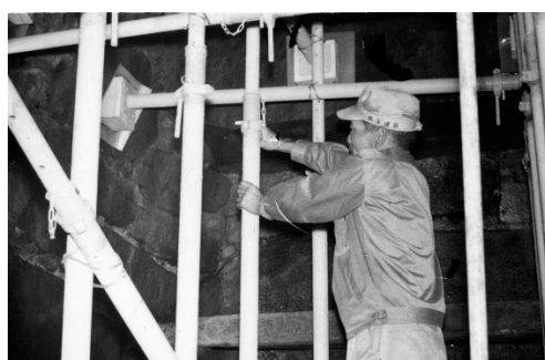
図 2-88：石室内鋼管支柱取付工事 (昭和 42 (1967) 年)
