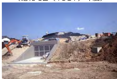
図 2-95：墳丘復元工事(平成元 (1989) 年度)
