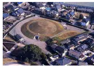
図 2-99：石室浸水対策及び後円部復元工事後の王塚古墳(平成 14 (2002) 年度)
