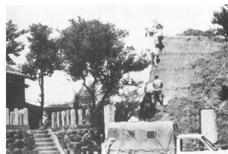
図 2-90：シートの設置(昭和 47 (1972) 年)
