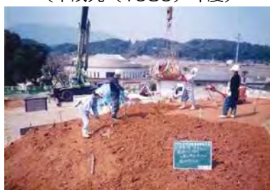
図 2-98：石室浸水対策工事(平成 14 (2002) 年度)
